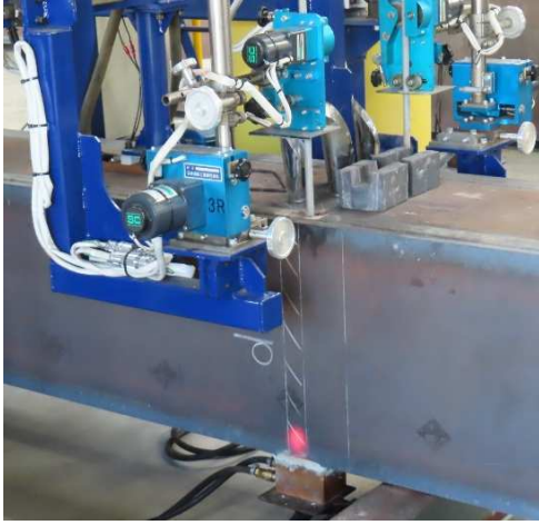
写真12 エレクトロスラグ溶接中のBOX柱
