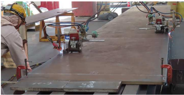
写真2 開先加工用ポータブルガス切断機
