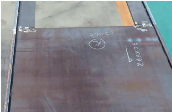
写真7 BOX柱角溶接前の状態
