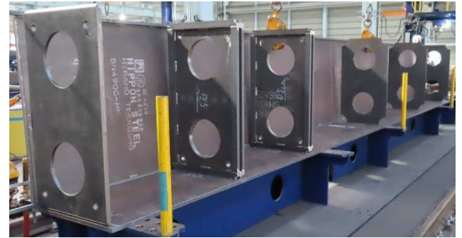
写真5 コ形組立状況
