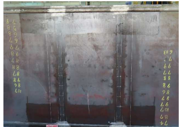
写真19 超音波探傷検査が完了したBOX柱
