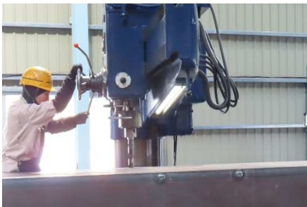
写真13 第二エレクトロスラグ溶接用孔明加工
