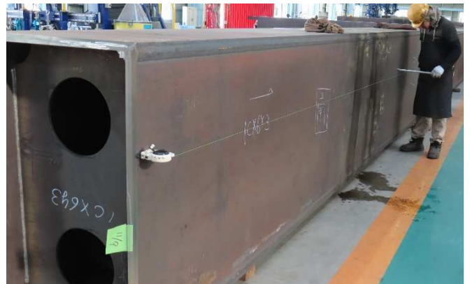
写真16 BOX柱素管の大曲計測
