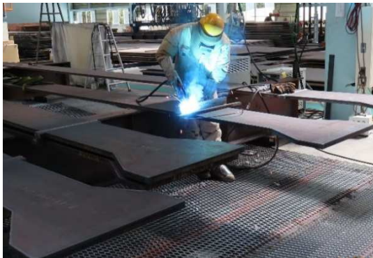
写真4 ガスマタルアーク溶接を用いた板継状況
