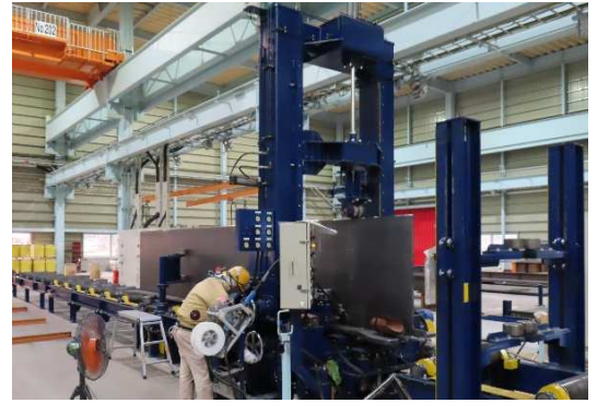
写真5 仮組立溶接実施状況
